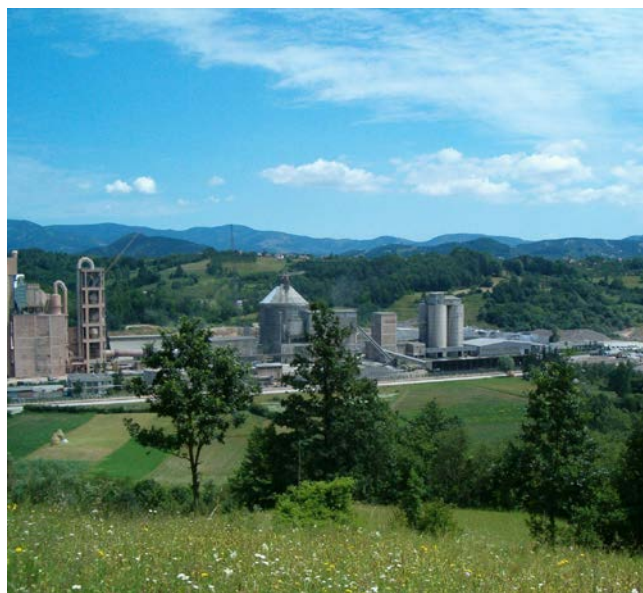
Εργοστάσιο τσιμέντου Kosjeric, Σερβία
