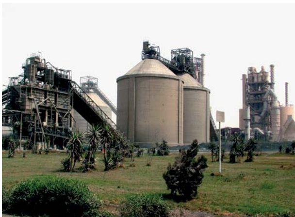
Εργοστάσιο τσιμέντου Beni Suef, Αίγυπτος
