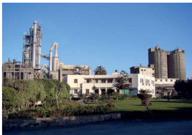
Εργοστάσιο τσιμέντου Alexandria, Αίγυπτος
