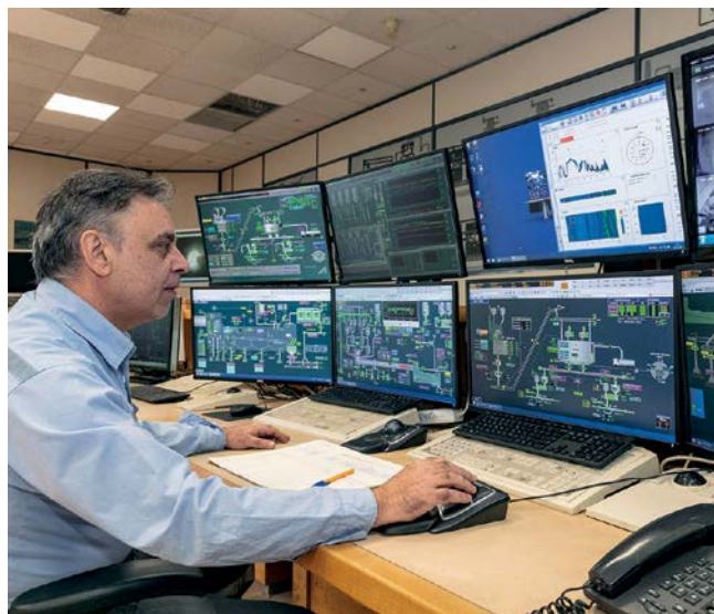
Εργοστάσιο τιμέντου Καμαρίου, Ελλάδα
