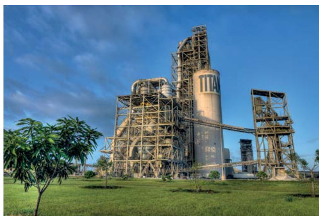
Εργοστάσιο τσιμέντου Pennsuco, ΗΠΑ
