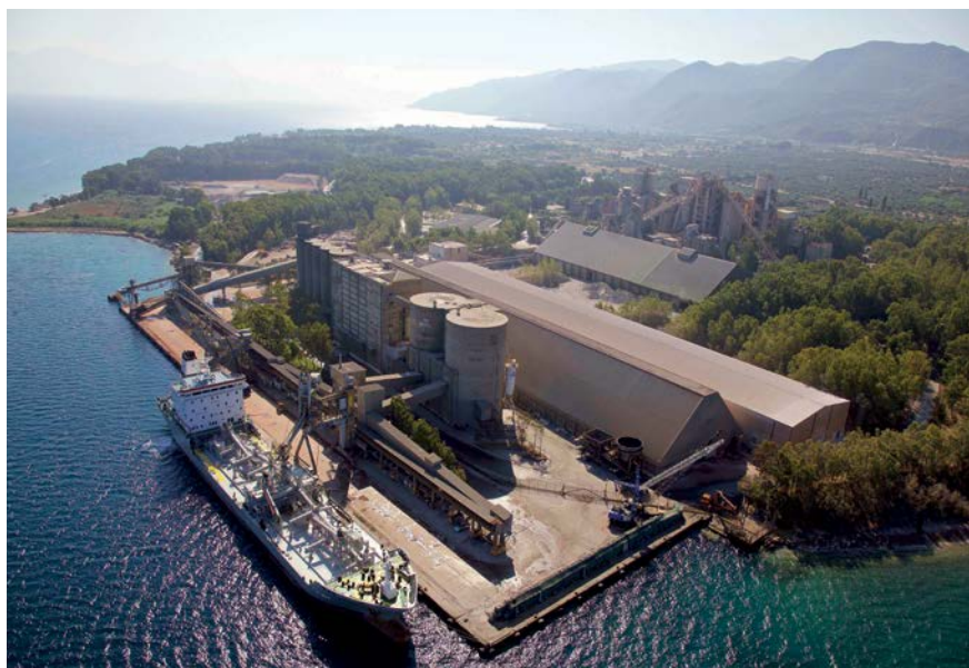
Εργοστάσιο τσιμέντου Πάτρας, Ελλάδα
